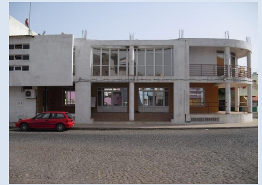
Edifício Técnico utilizado para vistoria
